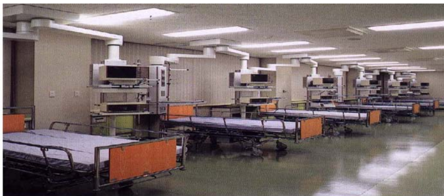
Gambar L1 – Contoh Model Ruang Rawat Pasien ICU dengan ceiling pendant
